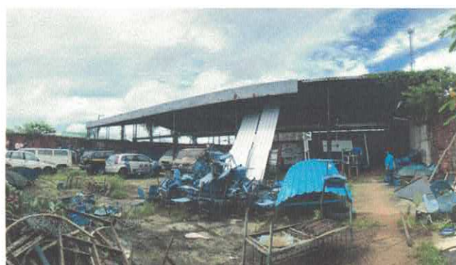
VISTA LATERAL DO GALPÃO
