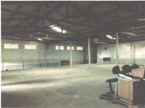
ÁREA INTERNA DO GALPÃO
