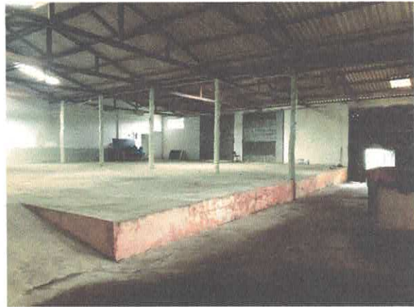
ÁREA INTERNA DO GALPÃO
