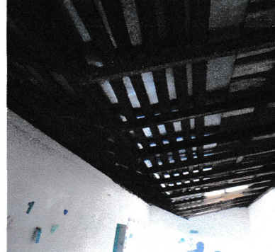
FOTO 02: Correção do sistema de cobertura;
