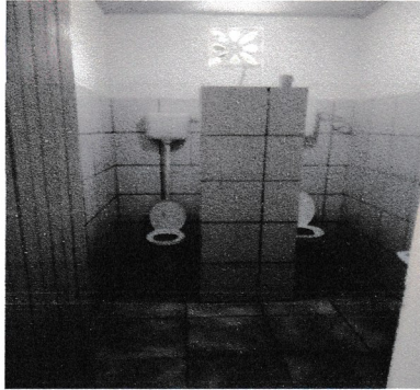
FOTO 01: Instalar portas internas dos banheiros;
