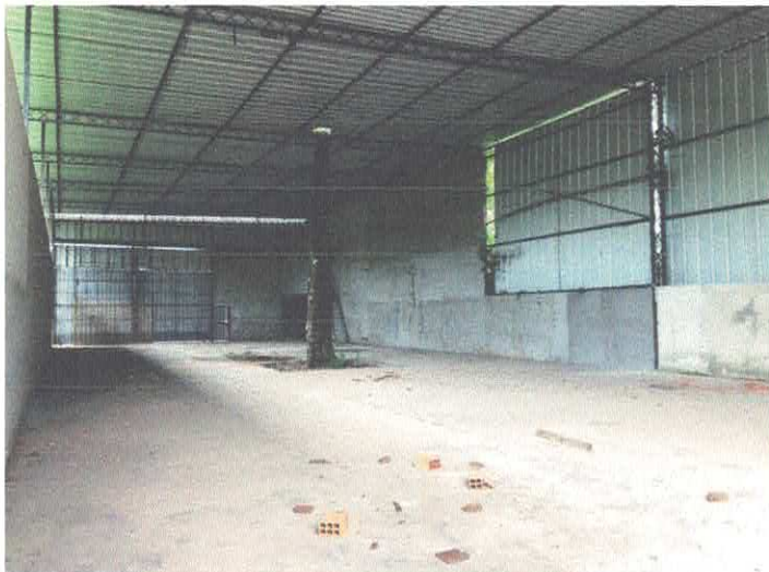
VISTA INTERNA DO GALPÃO
