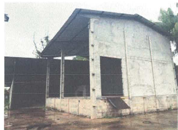
VISTA EXTERNA DO GALPÃO
