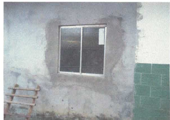
VISTA LATERAL DA EDIFICAÇÃO DE 01 PAVIMENTO
