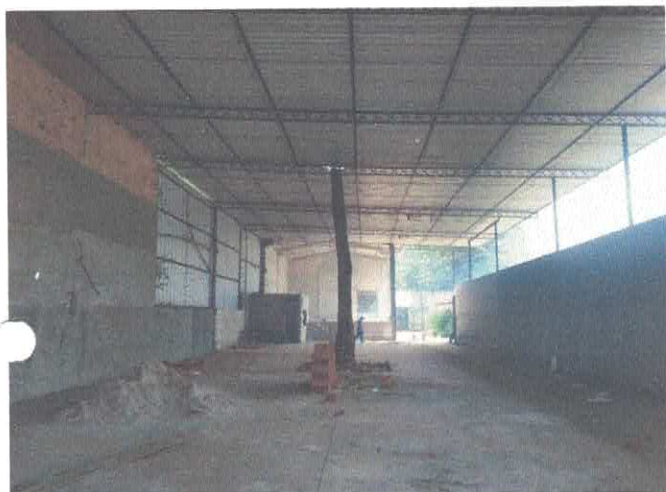
VISTA INTERNA GALPÃO
