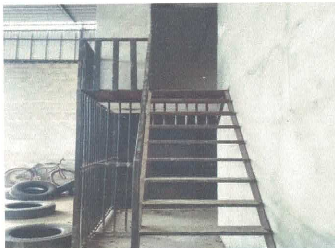
VISTA ESCADA MEZANINO
