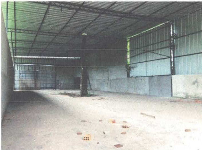
VISTA INTERNA DO GALPÃO
