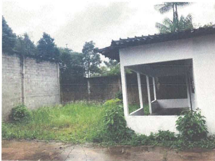
ÁREA LIVRE FRONTAL DA EDIFICAÇÃO DE 01 PAVIMENTO
