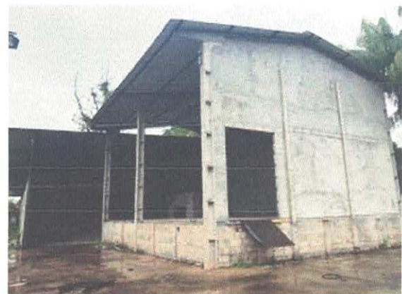
VISTA EXTERNA DO GALPÃO
