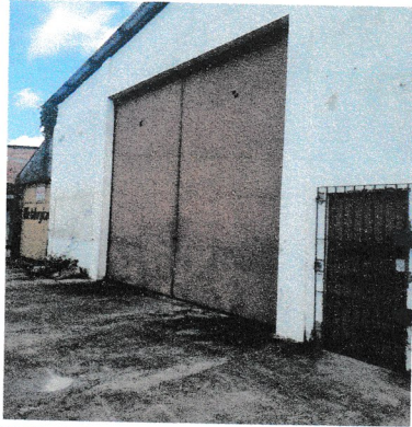
Área da frente do galpão
